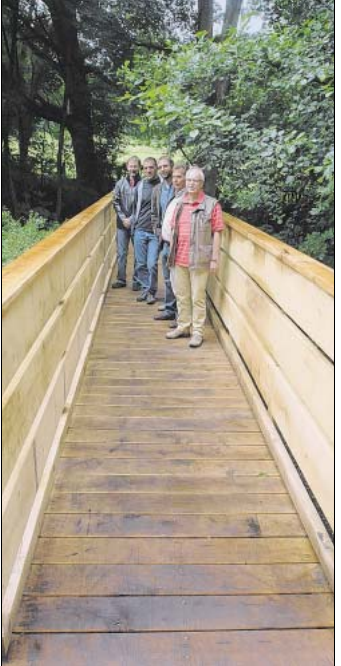
Die Vertreter der ausführenden Firmen und der Stadt Balve sind sicher, dass die neue Brücke 40 Jahre hält. Foto: Stefan Scherer
